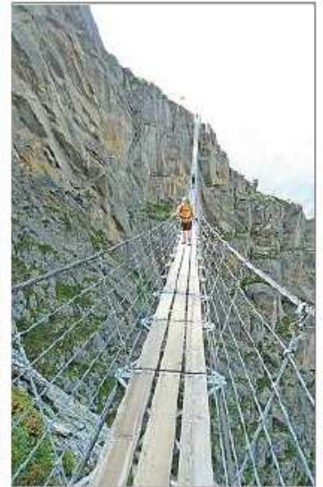
Spannung garantiert die 90 Meter lange Hängebrücke auf dem Weg zur Voralphütte. Fotos: pr.
