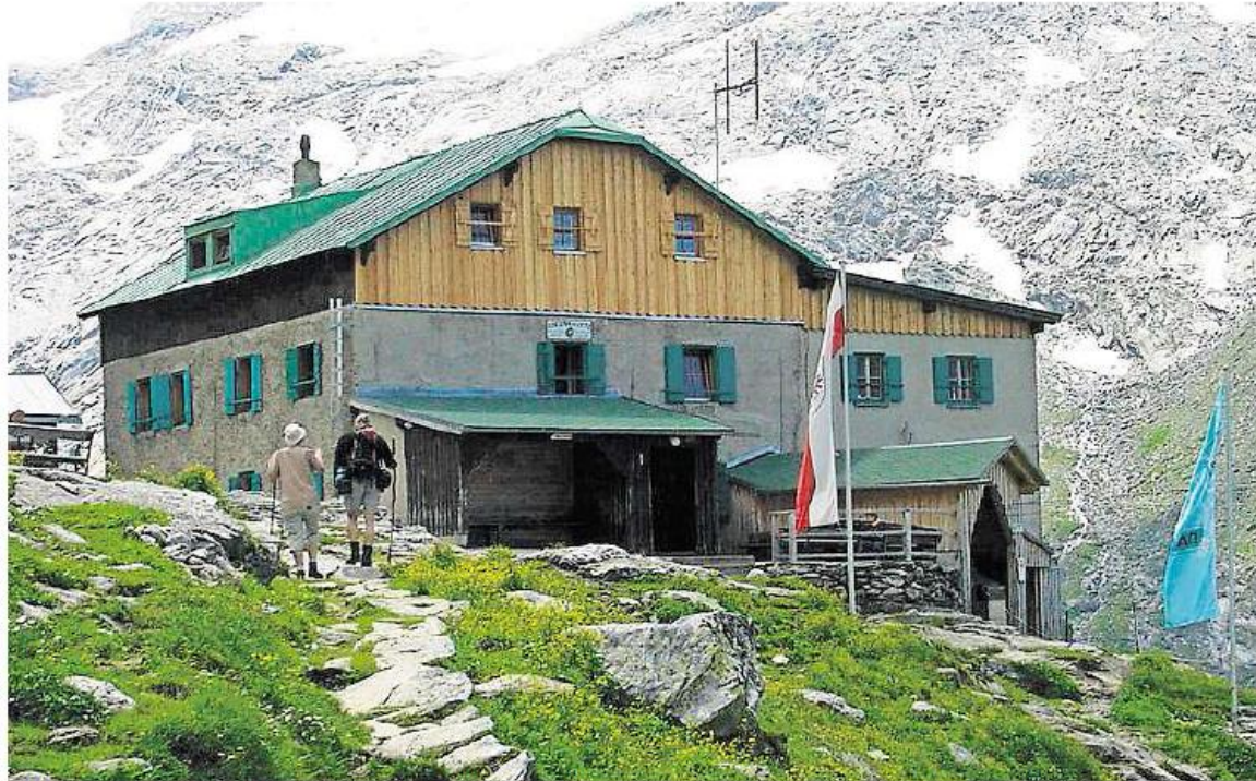
Ein Plus von 22 Prozent bei den Übernachtungszahlen verzeichnet die Greizer Hütte. Im Juni beginnt die Sanierung der Abwasser-Anlage.
